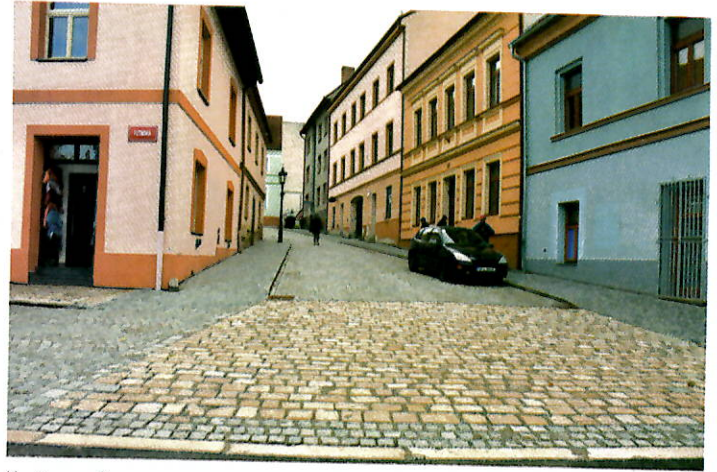
Kocínova ulice po opravě.
