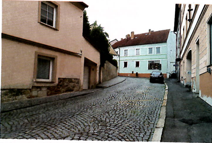
Kocínova ulice před rekonstrukcí povrchu.
