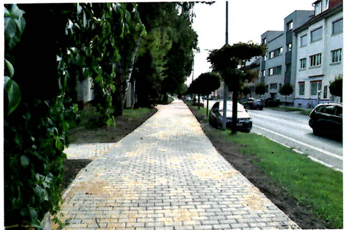
Starou dlažbu v části Nádražní ulice nahradila dlažba zámková.
