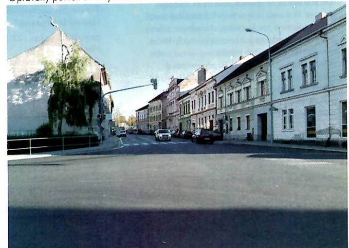
Nový povrch má i část Budějovické ulice.
