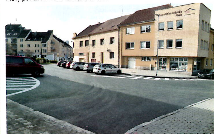
V části ulice Švantlova byl položen nový povrch, nové je i vodorovné dopravní značení.
