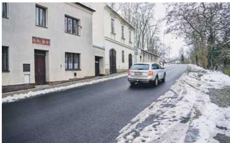
PŘED NÁSTUPEM SKUTEČNÉ ZIMY také skončila oprava povrchu v ulici Pražská.
