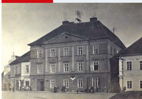
Objekty bývalé pošty Tábor 2 před jejich adaptací v roce 1910.
